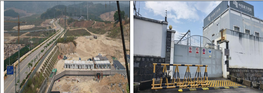
汉弄 220kV 变电站新建 220kV 储能站现状
