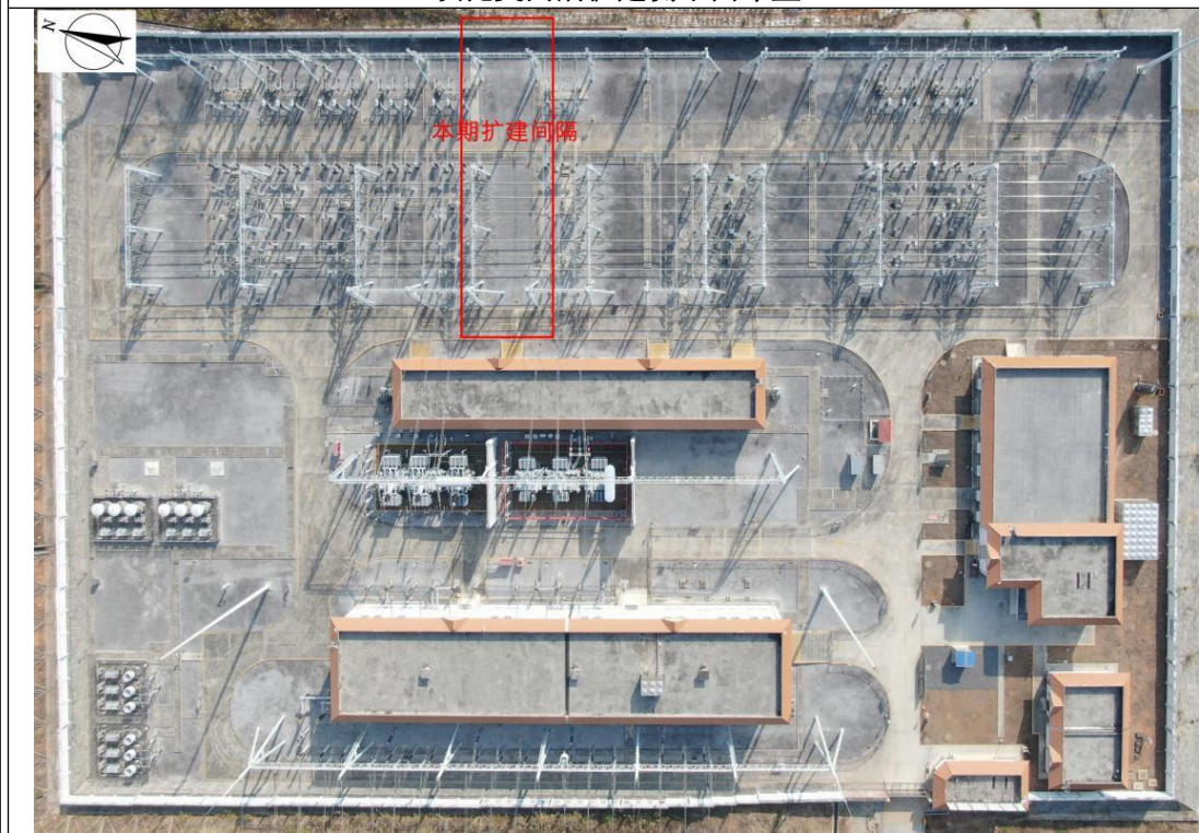
坝托变间隔扩建侧俯拍图
