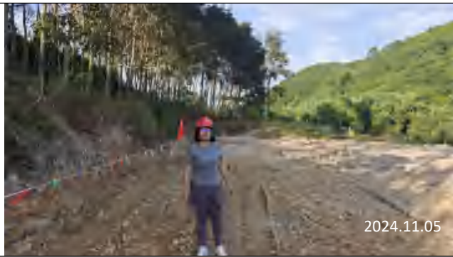
工程师现场照片（苏典乡升压站）
