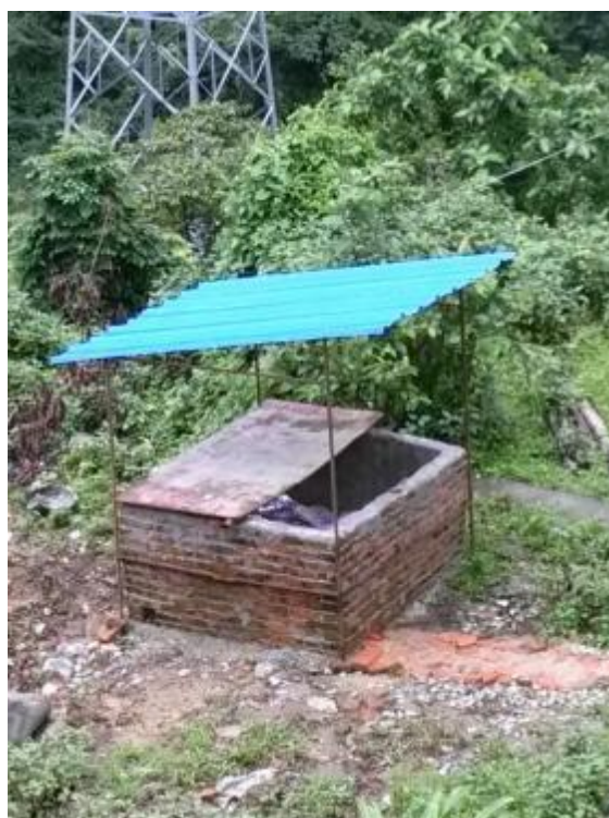
生活区垃圾收集池
