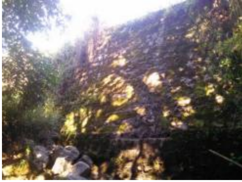
3#弃渣场（厂房下游处，挡墙）
