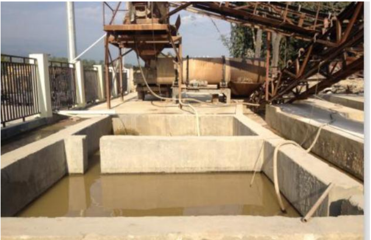
生产废水沉淀池
