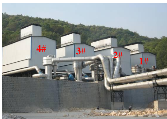
1#、2#、3#、4#12500KVA 半密闭矮烟罩矿热电炉烟气和出硅口、浇注烟气经集气罩+空冷器+旋风除尘器+布袋除尘器
