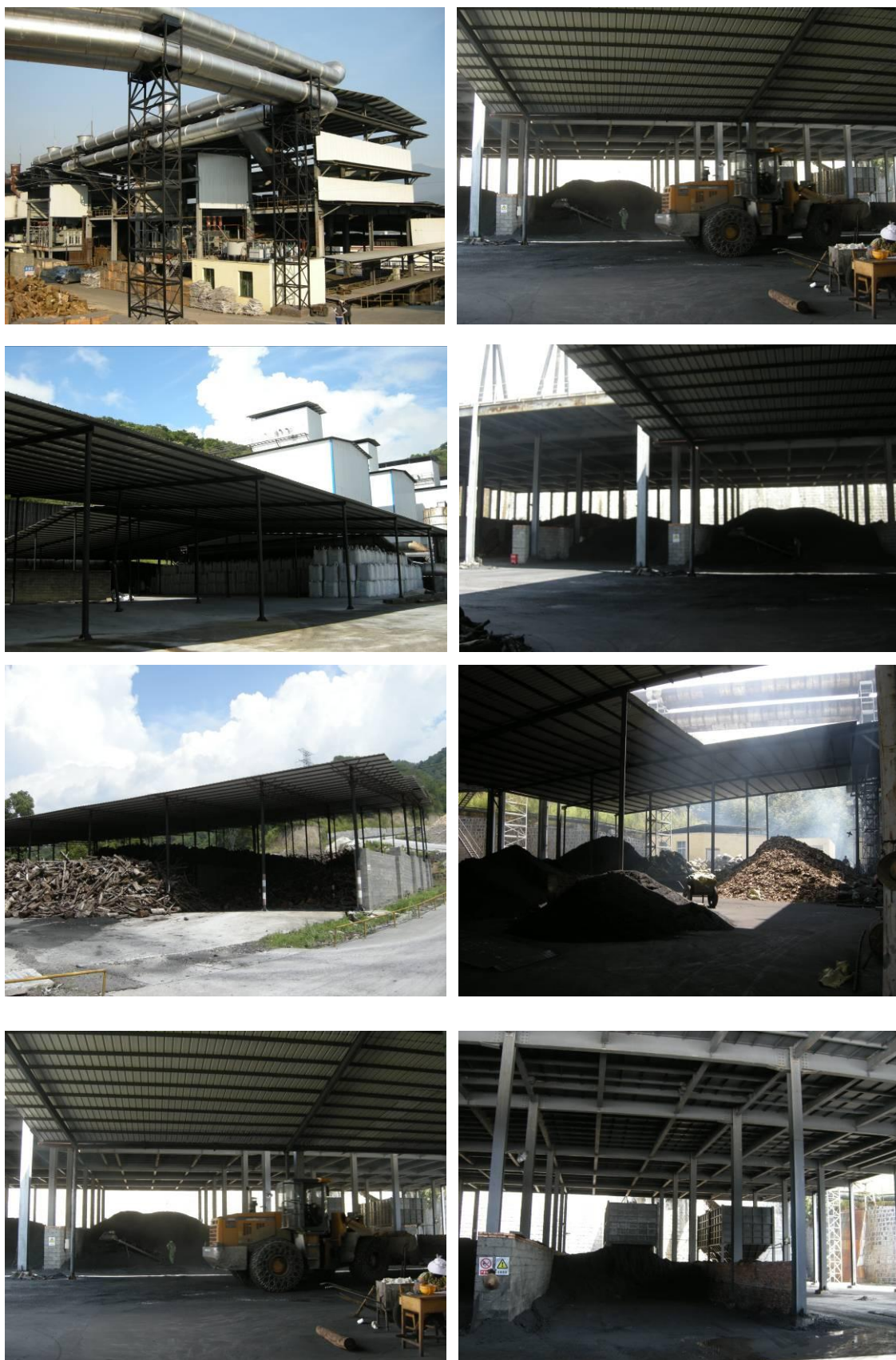
1#、2#、3#、4#12500KVA 半密闭矮烟罩矿热电炉生产厂房及原料、产品堆棚
