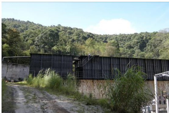
高位水池及冷却循环系统 (2500m 3 )
