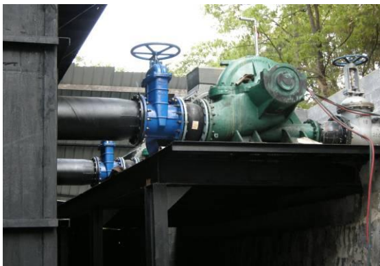
低位回水池及循环回用系统 (1500m 3 )
