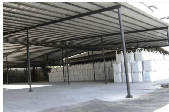
除尘灰(微硅粉)堆棚
