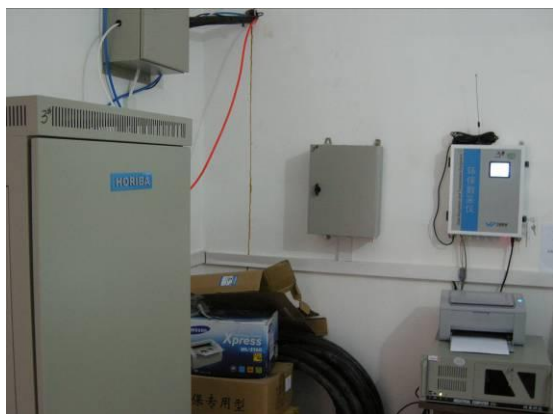
3#、4#12500KVA 矿热电炉烟气和出硅口、浇注烟气经集气罩+空冷器+旋风除尘器+布袋除尘器出口烟气在线监测系统
