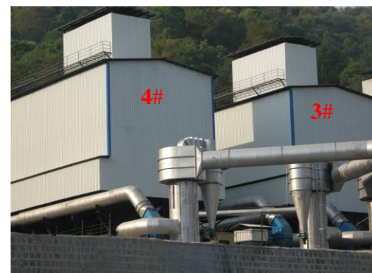
1#、2#、3#、4#12500KVA 半密闭矮烟罩矿热电炉烟气和出硅口、浇注烟气经集气罩+空冷器+旋风除尘器+布袋除尘器
