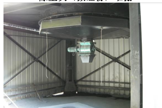
除尘器密闭除灰系统及除尘灰(微硅粉)包装
