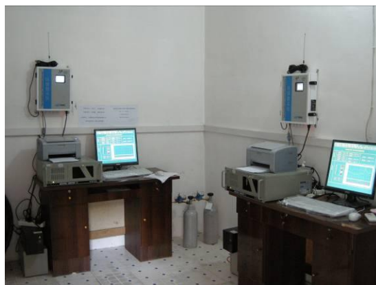
3#、4#12500KVA 矿热电炉烟气和出硅口、浇注烟气经集气罩+空冷器+旋风除尘器+布袋除尘器出口烟气在线监测系统
