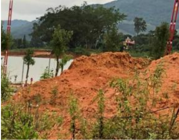
图 5.3-3 场区人工填土
