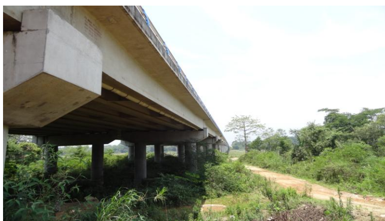
桥下植被恢复
