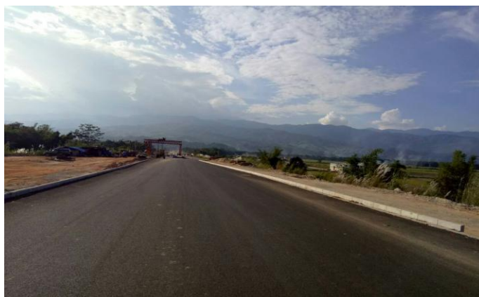
1#施工场地拌合站所在地
