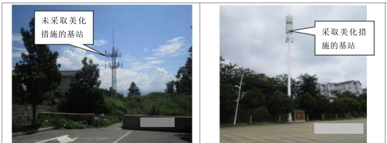
图 8-2 落地塔类型基站对景观的环境影响对比
