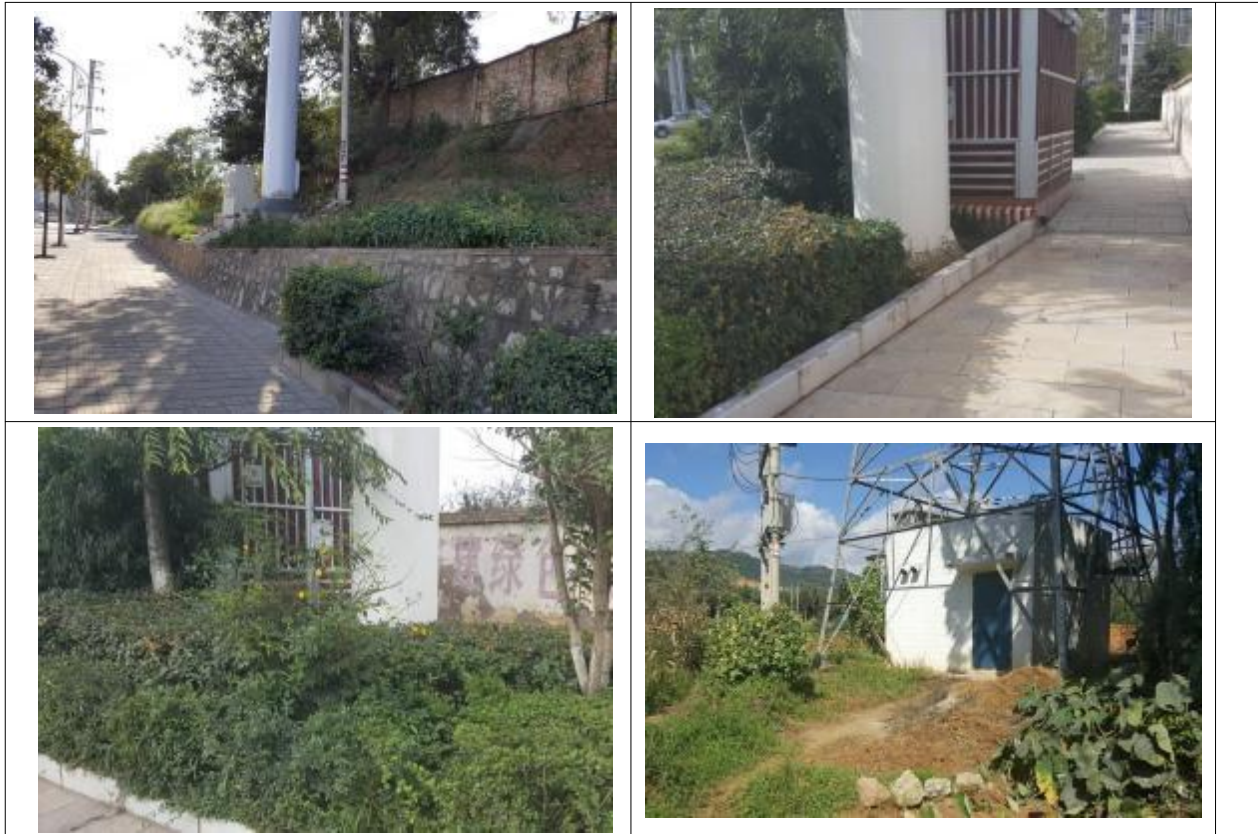
图 8-1 塔基处生态环境恢复情况
