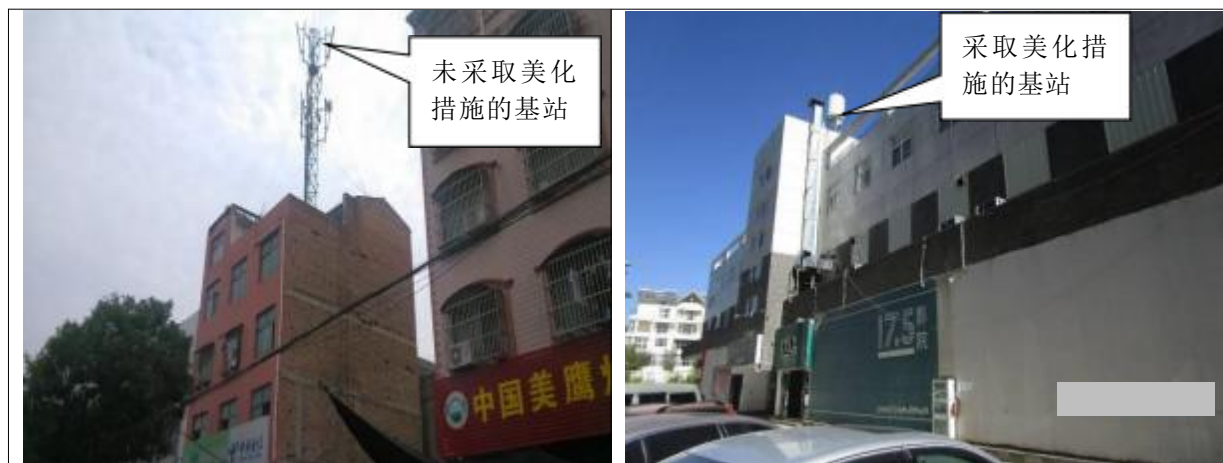
图 8-3 楼顶塔类型基站对景观的环境影响对比
