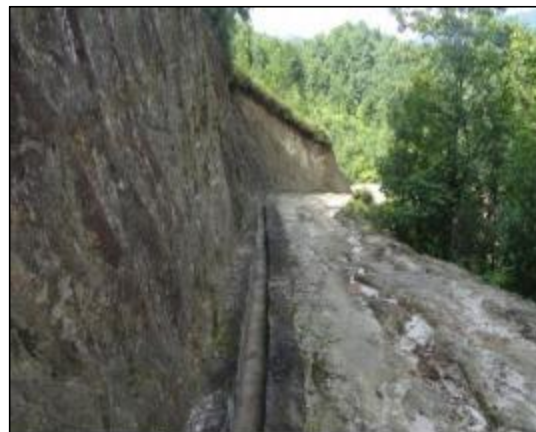
道路边排水沟情况
