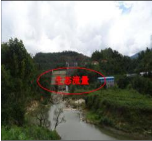
冲沙闸检修闸处生态泄流
