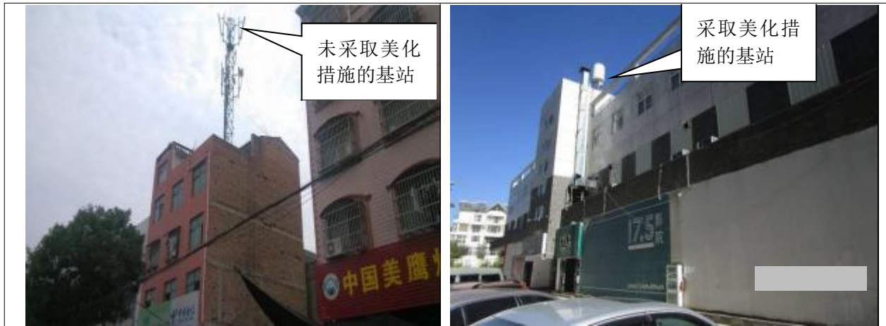
图 8-3 楼顶塔类型基站对景观的环境影响对比
