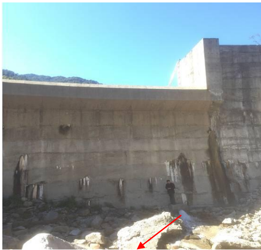
二级大坝生态排放口
