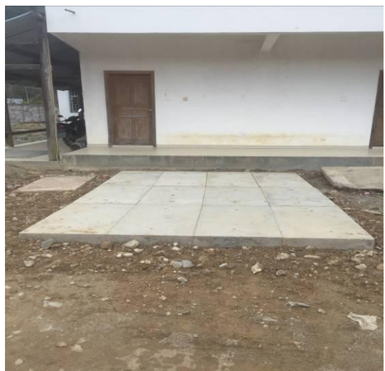
生活污水收集池
