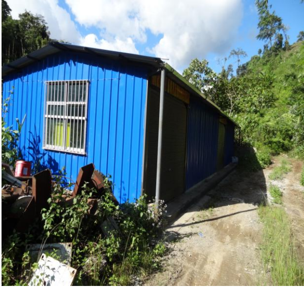
危险品存储室
