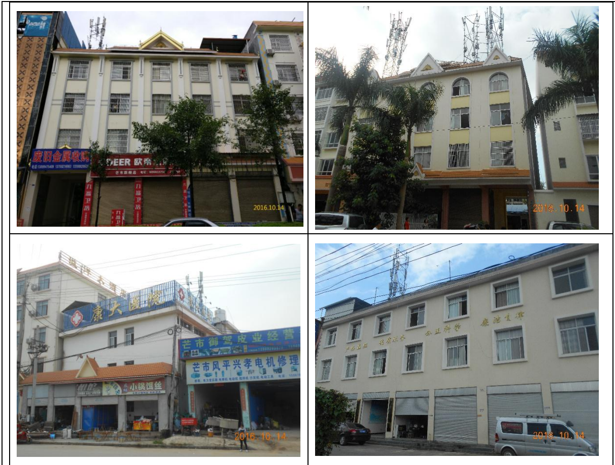
图 8-3 楼顶塔类型基站对景观的环境影响
