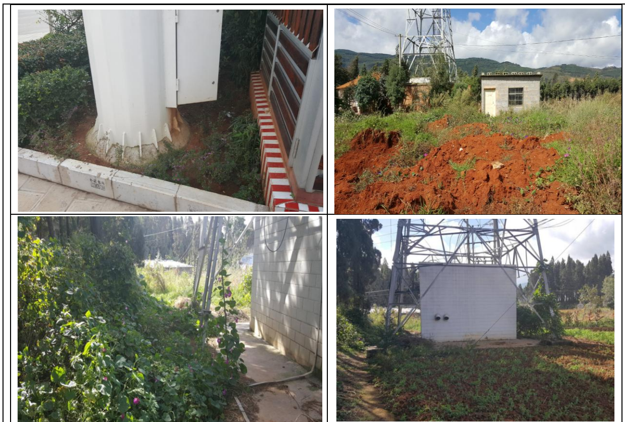
图 8-1 塔基处生态环境恢复情况
