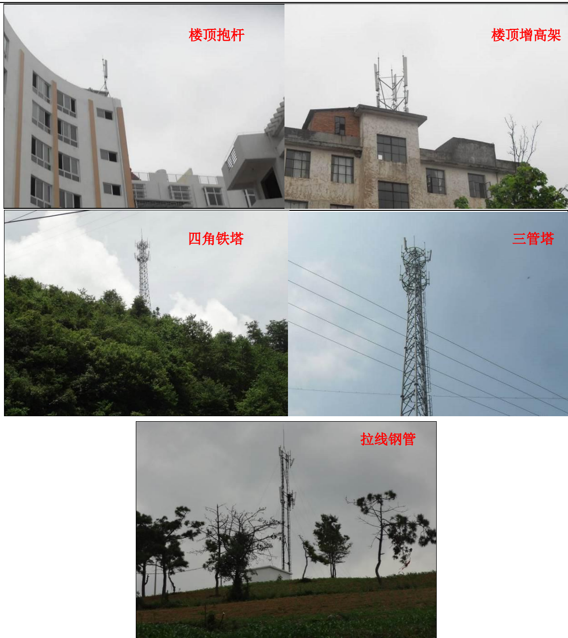
图 4-3 基站天线架设方式实例
