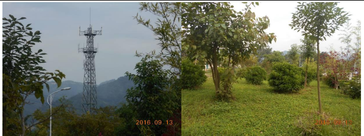
图 8-1 塔基处生态环境恢复情况
