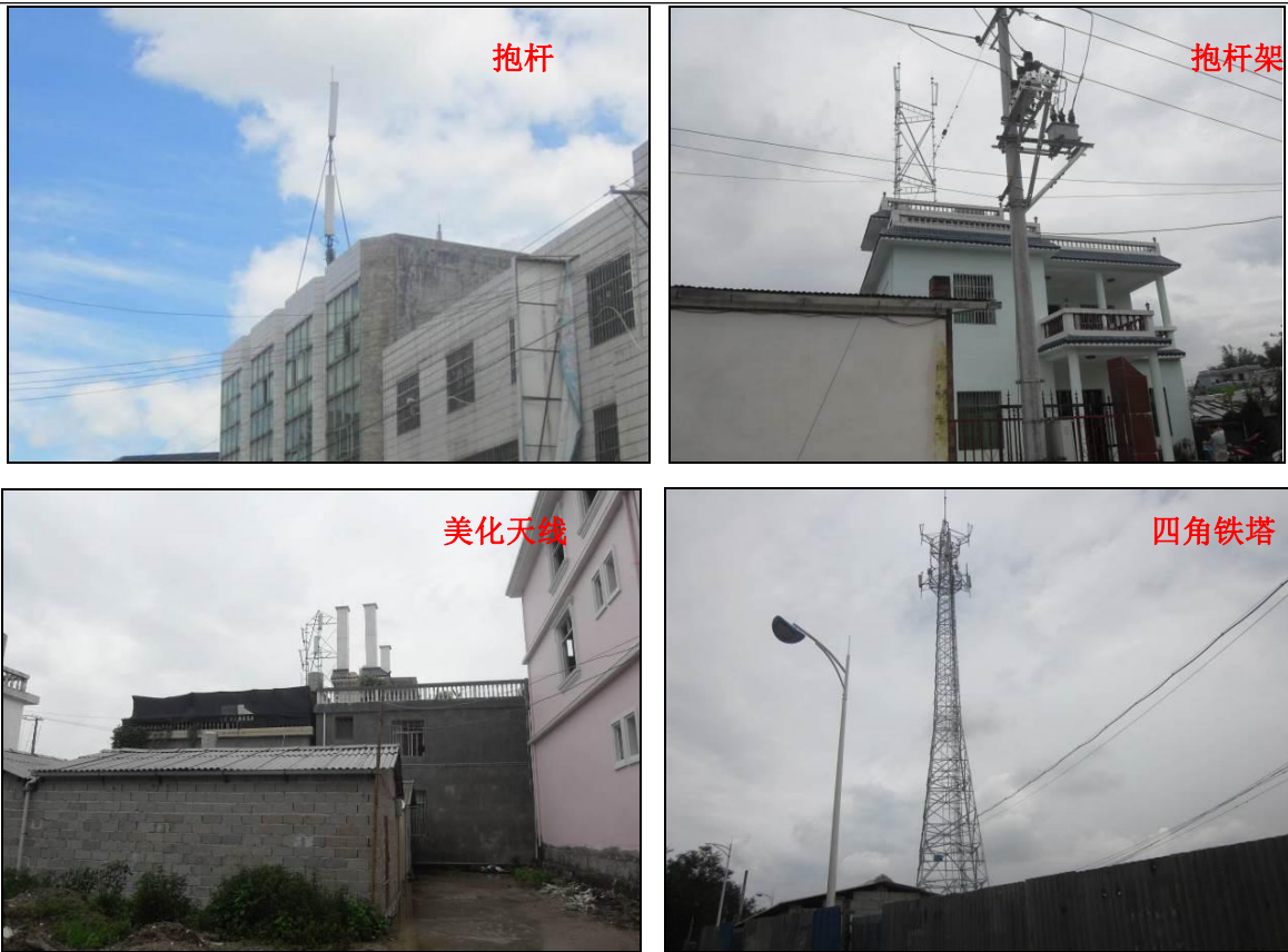
图 4-3 基站天线架设方式实例
