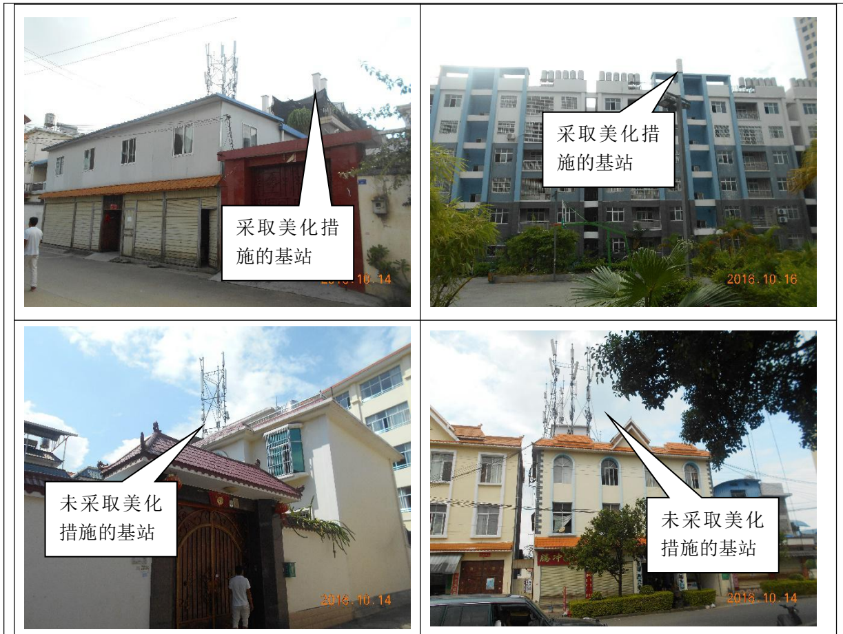
图 8-3 楼顶塔类型基站对景观的环境影响
