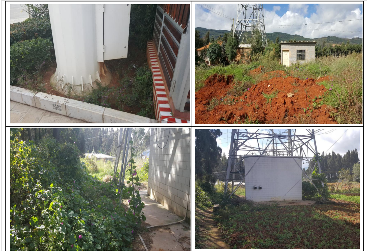
图 8-1 塔基处生态环境恢复情况
