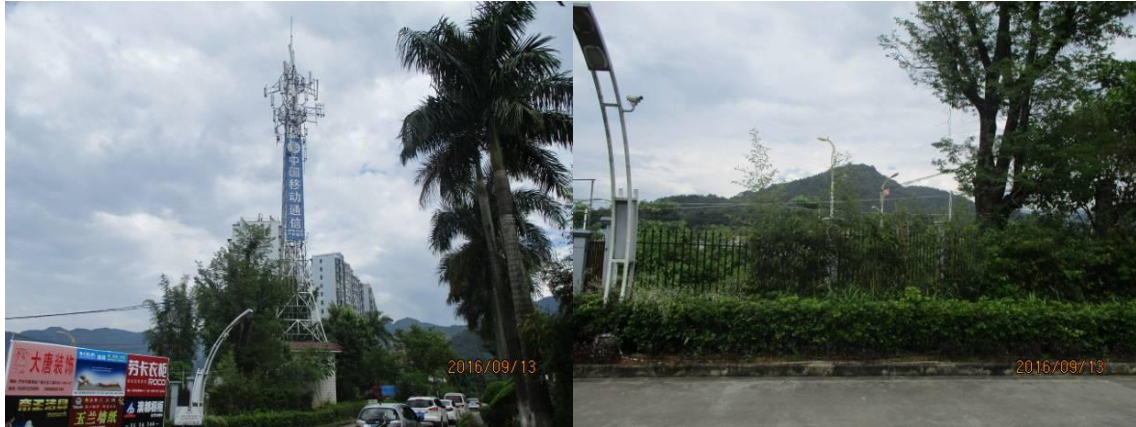
图 8-1 塔基处生态环境恢复情况
