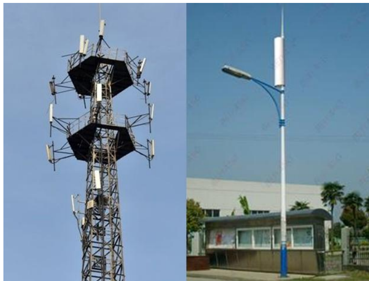
图 3 落地塔架设方式的基站
