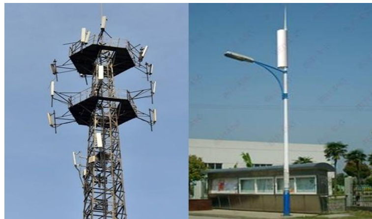
图 3 落地塔架设方式的基站
