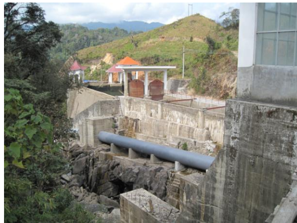
图 5-2 二期压力管道侧面
