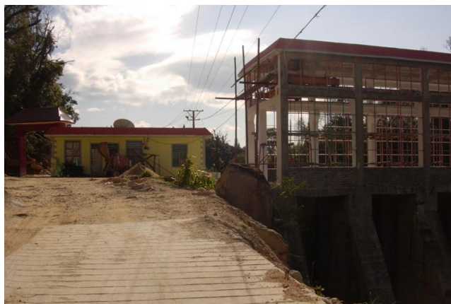
图 6-15 首部大坝及值班房舍
