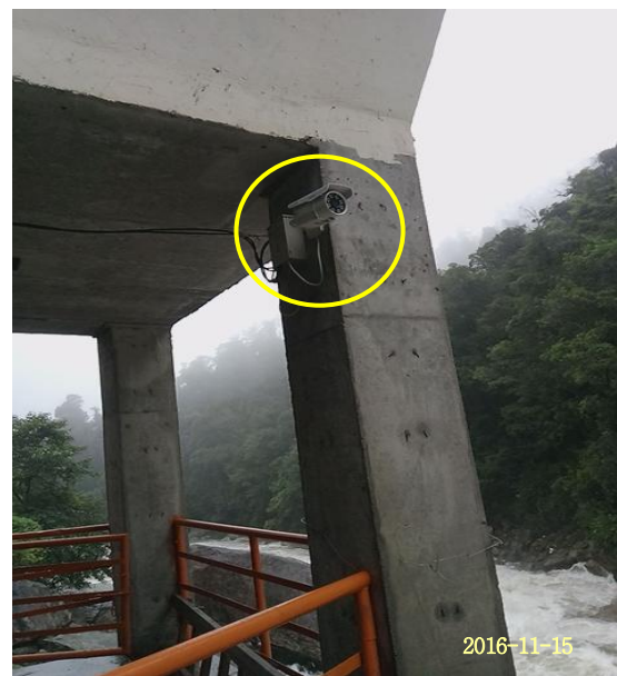
老二级站冲沙闸生态放流监控
