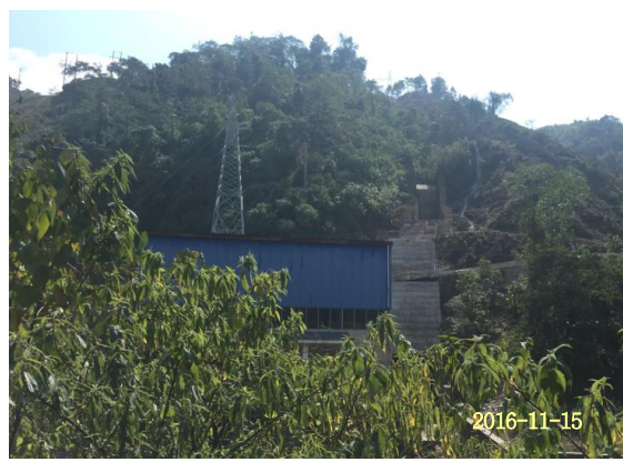
压力钢管上方地表植被
