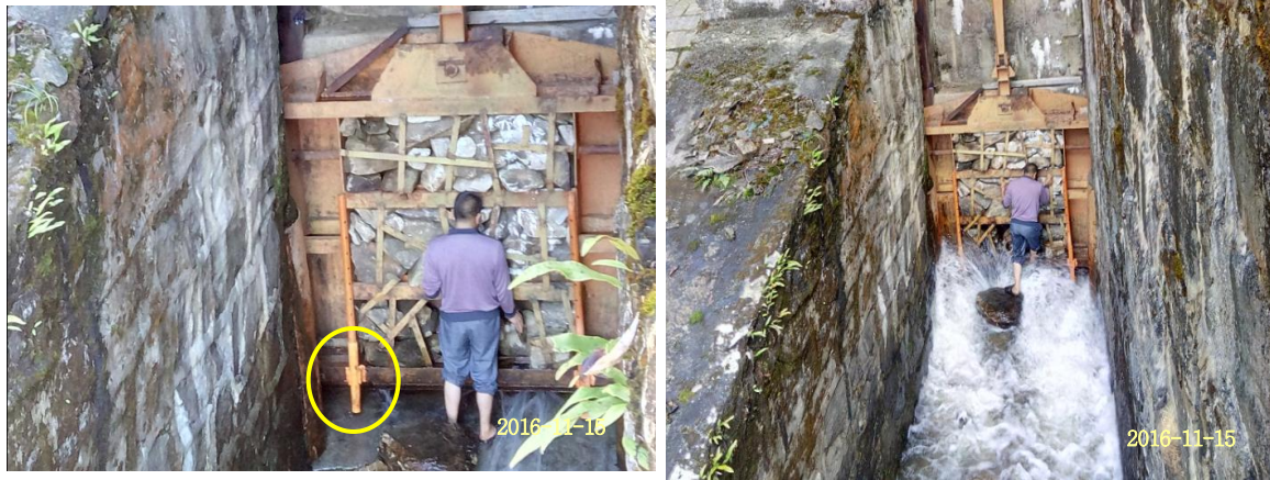
老二级站冲沙闸设下垫面进行放流
