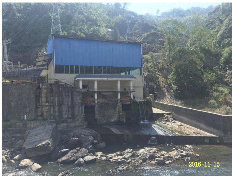
图 5.6-1 电站尾水溢流堰和护坡挡墙
