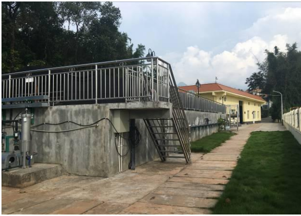
图片 17 渗滤液处理站 1
