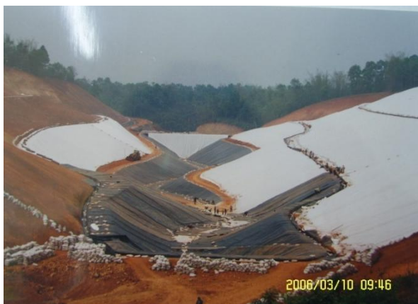
图 43 垃圾填埋场土建施工 1
