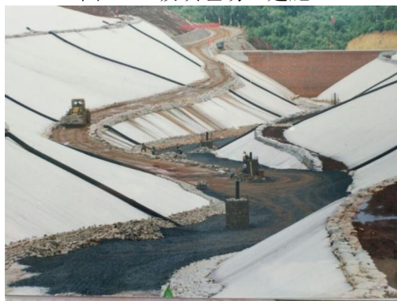
图 45 垃圾填埋场导气管
