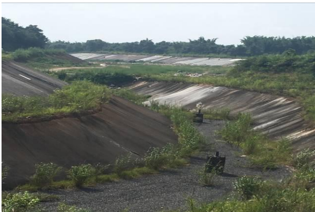
图片 5 填埋场二期排气系统及防渗层
