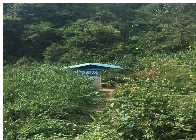
图片 16 渗滤液回喷泵房
