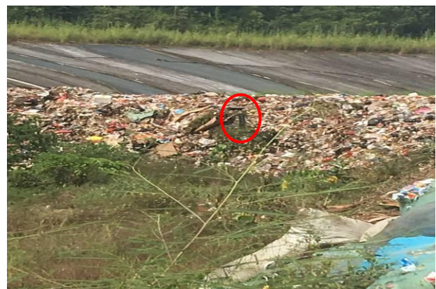
图片 6 填埋场一期排气系统
