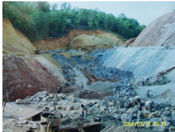
图 44 垃圾填埋场土建施工 2
