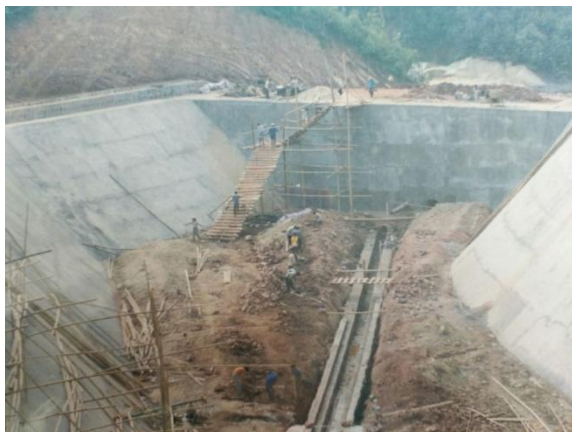
图 43 地下水导排管铺设
