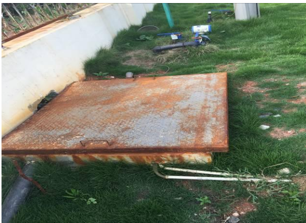
图片 21 处理站进水口
