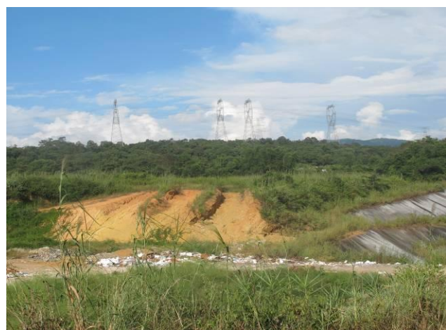
图片 38 垃圾填埋取土场
