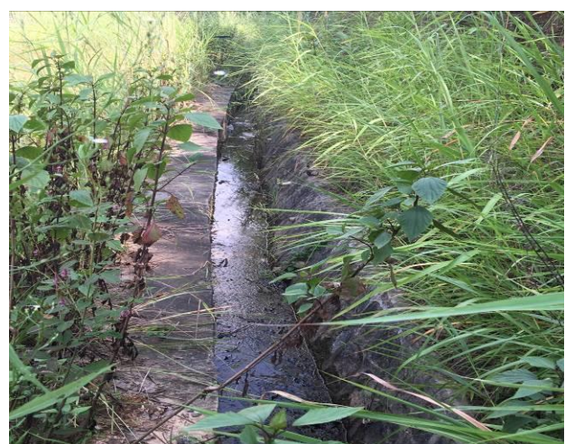
图片 8 填埋场周边排水沟
