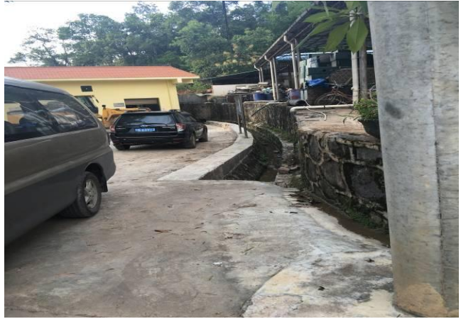
图片 26 处理站雨水沟
