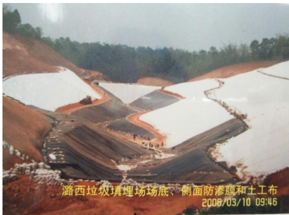
图 41 填埋场底部、侧面防渗工程施工
