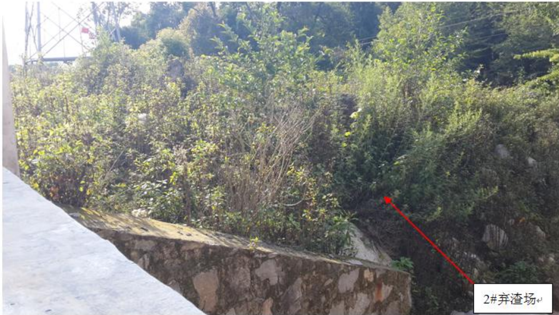
2#弃渣场恢复情况
