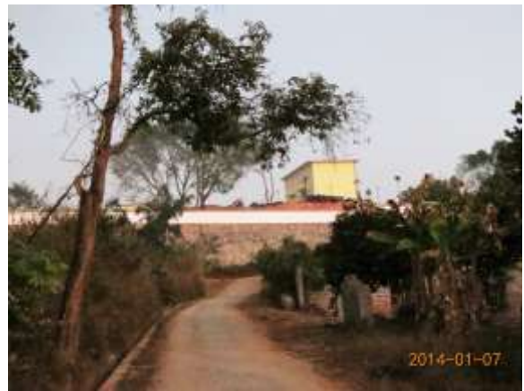
尚未投入使用的新自来水厂
