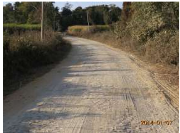
上雨路施工进场道路
