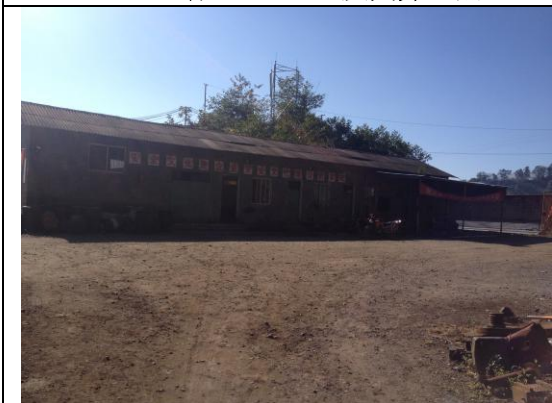
矿部 (办公、仓库、修理等)
