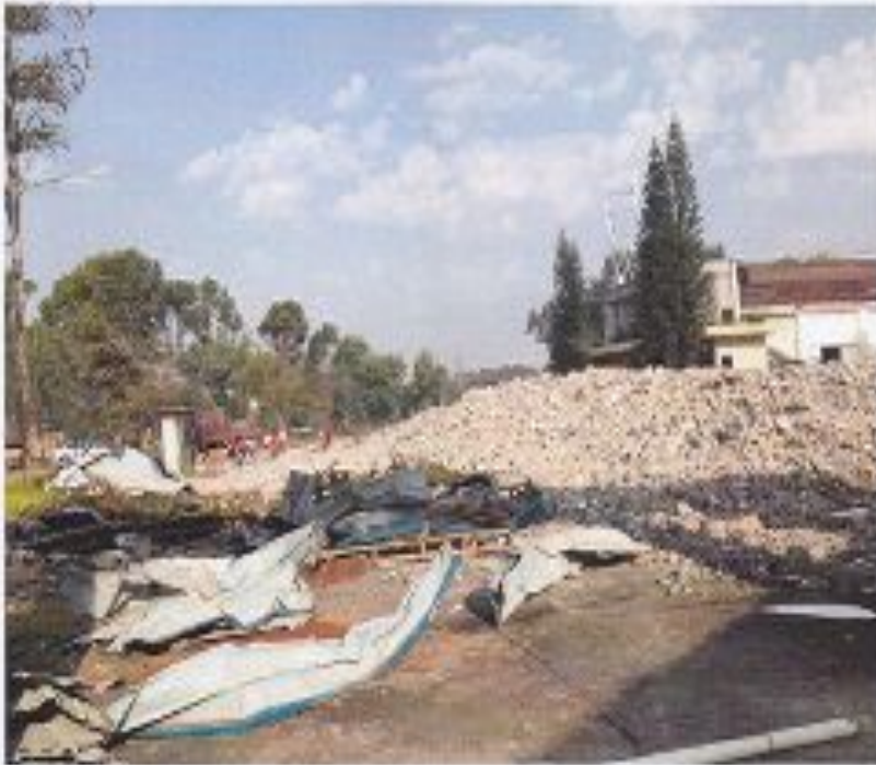
照片1 拆迁现场
