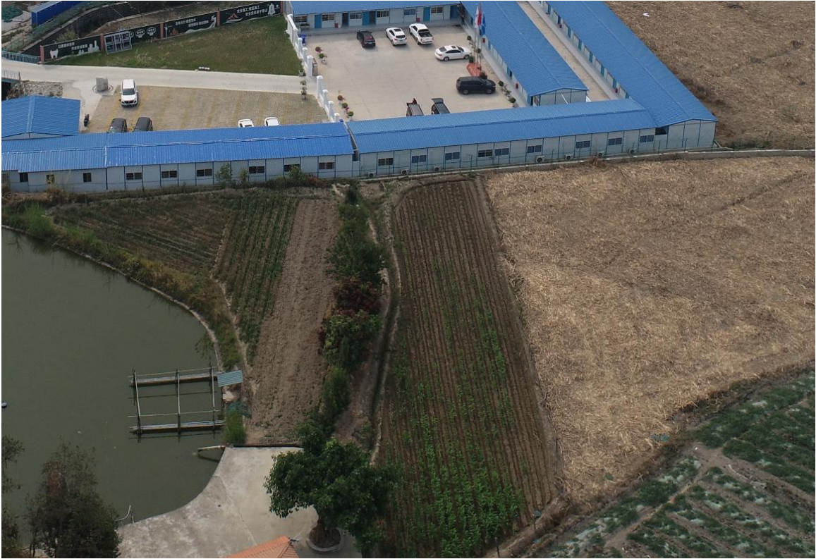
照片 4-9 现状沟渠
