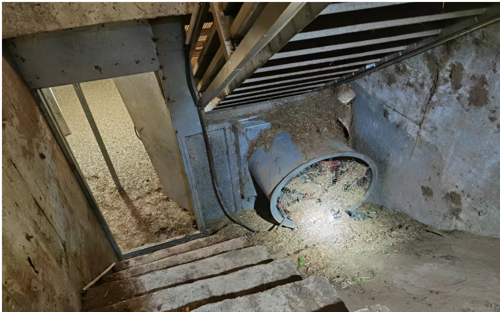
图 7.绿皮仓底部通风机
