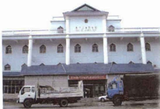
盈江口岸联检楼
