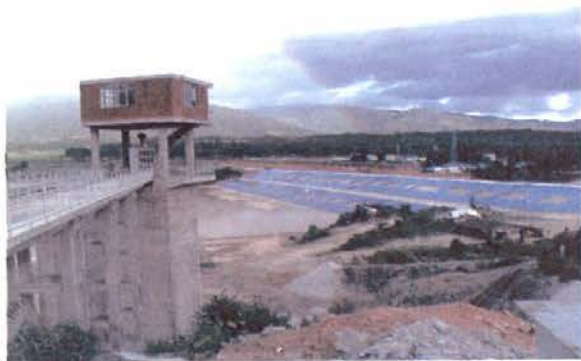
建设中的陇川麻栗坝水库
