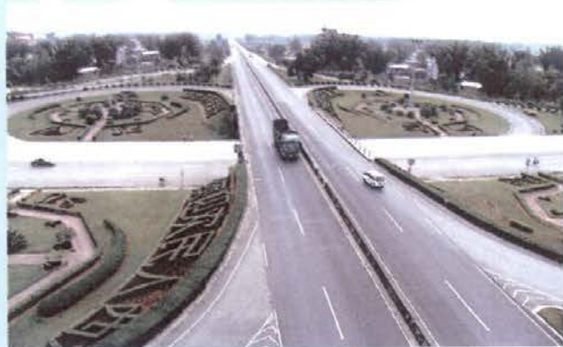
320国道芒市过境线
